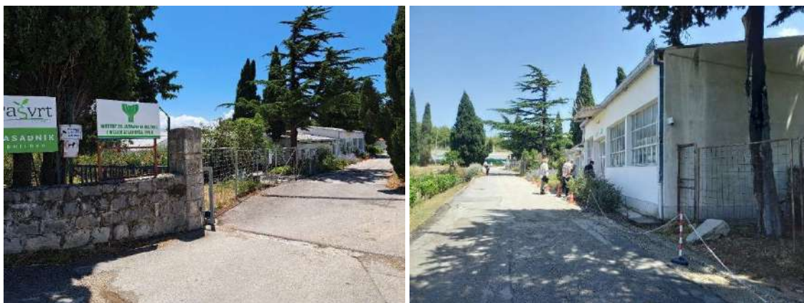
Slika 8. Postojeća zgrada A predviđena za rekonstrukciju
