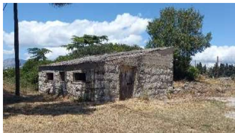
Slika 28. Pomoćna zgrada 1 (skladište za odlaganje opreme – k.č. br. 7372)
